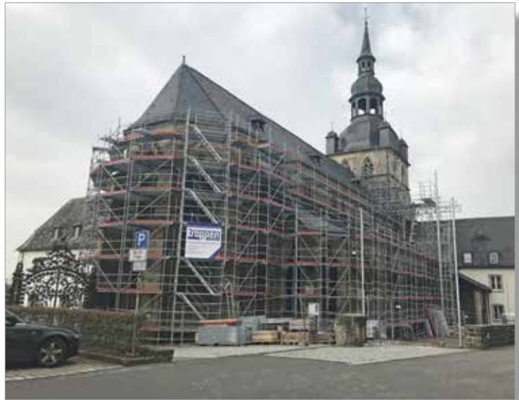
Kirche während der Einrüstung, Anfang 2018
