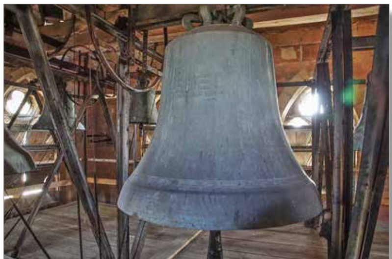
Blick in den Glockenstuhl vor der Sanierung
