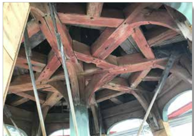
Blick in die Kehlbalkenlage der Turmlaterne
