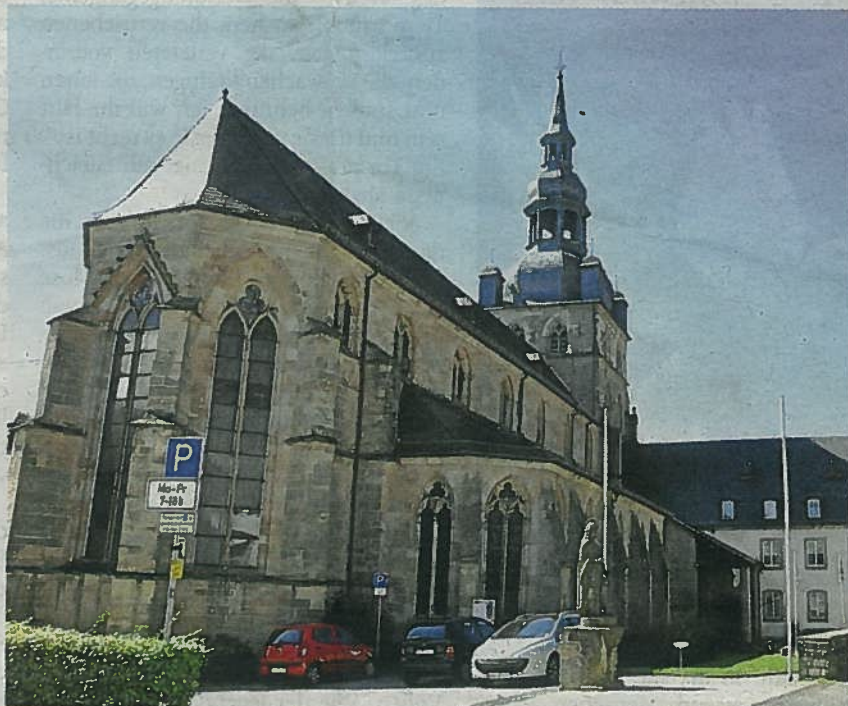
Die Abtei Tholey, ein Gebäude mit viel Geschichte. (Fotos: Bodo Bost)
